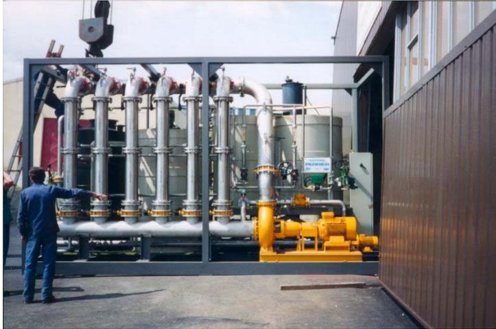
Figure 26 : Installation d'ultrafiltration
