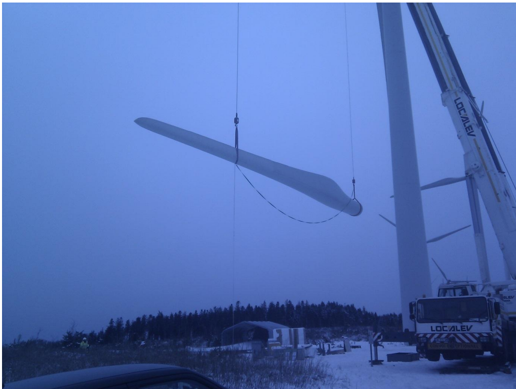
Figure 1 : démontage d'une pale afin de l'équiper du système de dégivrage
