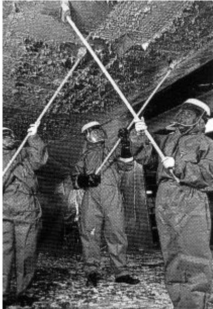
Décapage: procédé long et dangereux
